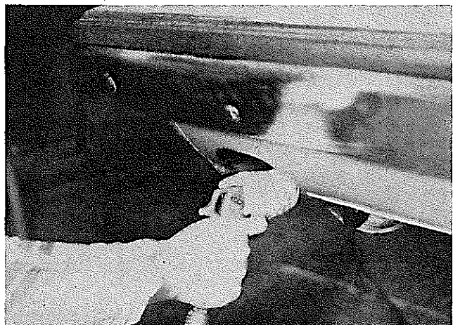
図2-8-51 ガス漏れ点検
