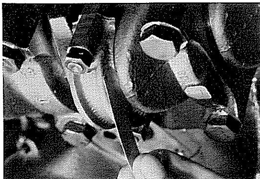
第1-44図 スラストすき間点検
