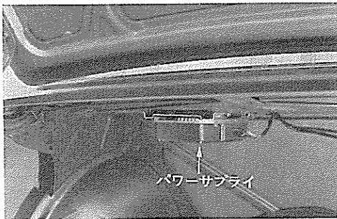
パワーサプライ取付の写真 B8530
